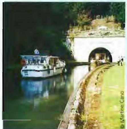
Lorsque la motorisation est apparue, les péniches devaient néanmoins traverser moteur arrêté, la ventilation du souterrain de Riqueval étant insuffisante pour pouvoir évacuer les gaz d'échappement des péniches, celles-ci doivent obligatoirement faire appel au «toueur». Le bateau treuil, de 25 m, doté de moteurs électriques, remorque les péniches à la vitesse de 2,5 km/h à l'aide d'une chaîne de 8 km, reposant sur le fond du canal et fixée à chaque extrémité du souterrain.
